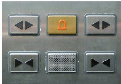
Gehören in jeden Lift: Notruftaste und Gegensprechanlage. Foto: TA
